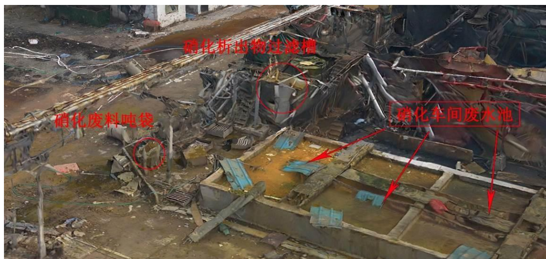
图3 硝化车间废水处理设施
